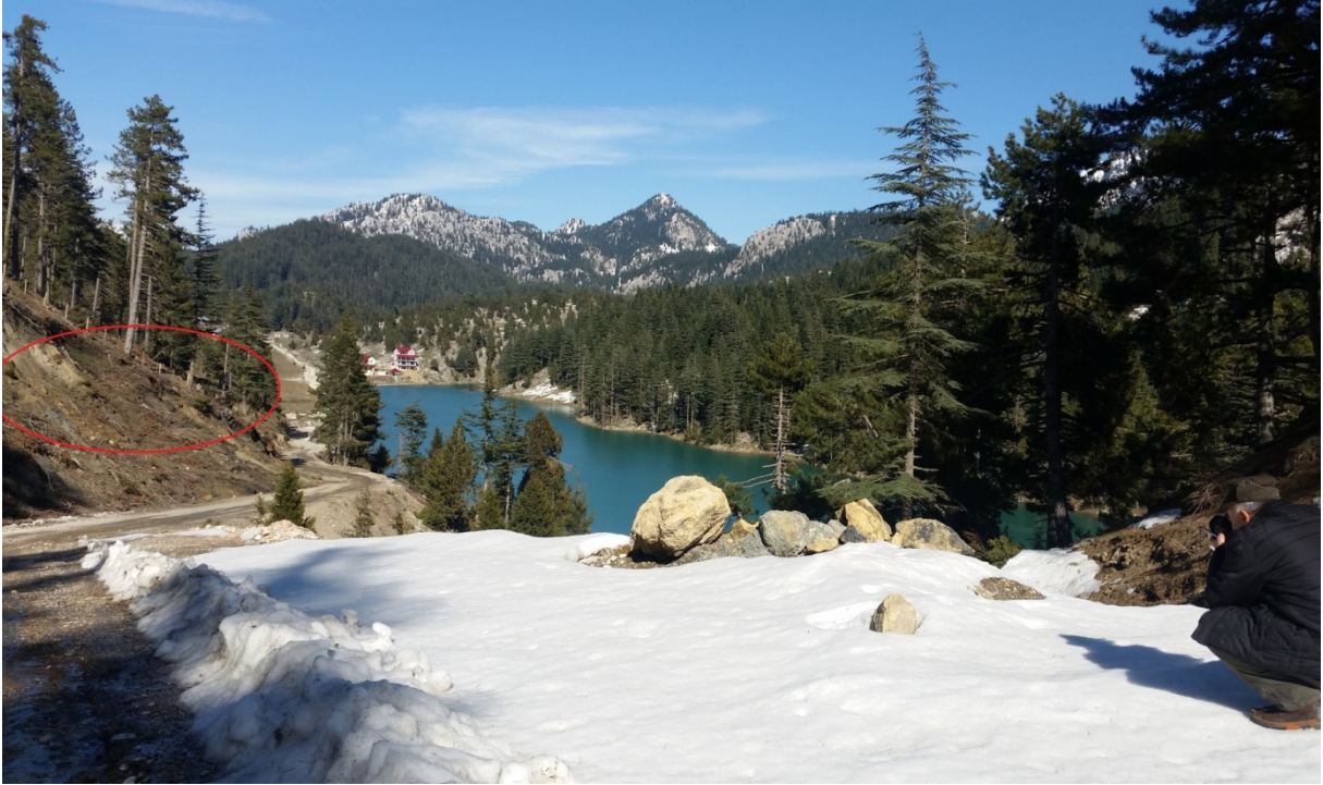
Şekil 17. Yol şevlerindeki erozyon
